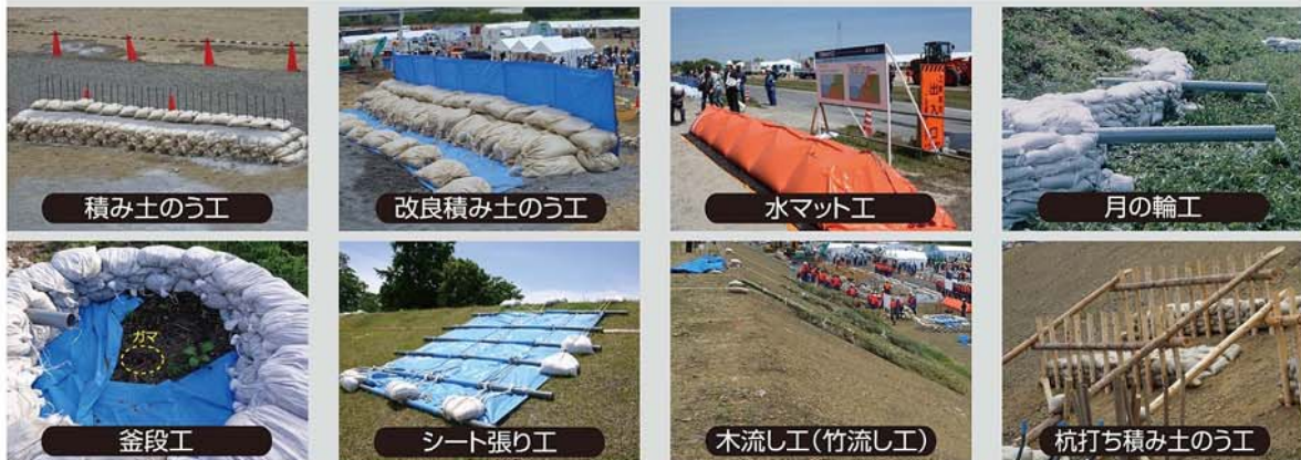
水防工法の一例写真
